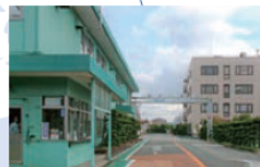
大阪工場/大阪研究所 電子材料部 TFT株式会社 ●界面活性剤、硫酸、防錆顔料、 導電性高分子薬剤、圧電材料等
