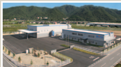
熊山工場【左側が工場棟、右側が事務所・研究棟】 (2006年9月)
