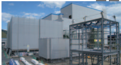
工事中的新製造設備(2018年10月に撮影)
