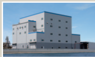
新設された機能性微粒子製品の製造設備
